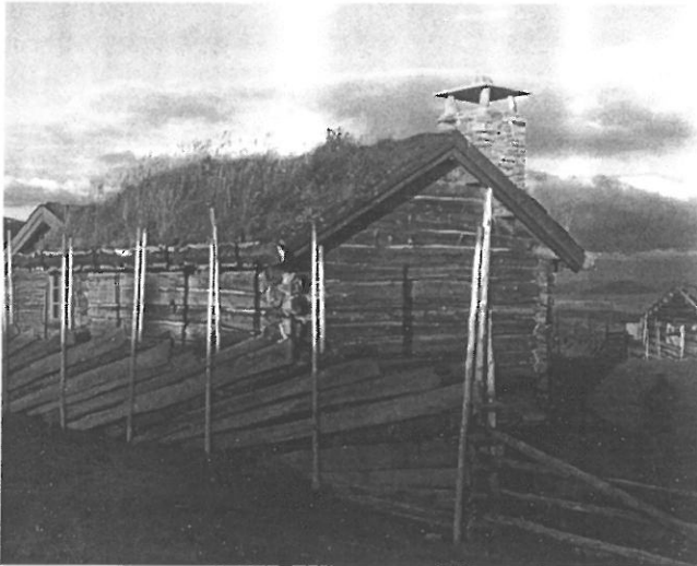
Gjenbruk og flytting av et gammelt tømmerhus er en god løsning for bygging på setervangen.
