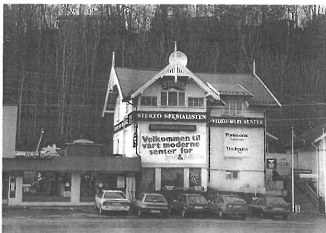
Skiltingen er for dominerende, er ikke tilpasset bygningen og virker skjemmende i forhold til omgivelsene.
