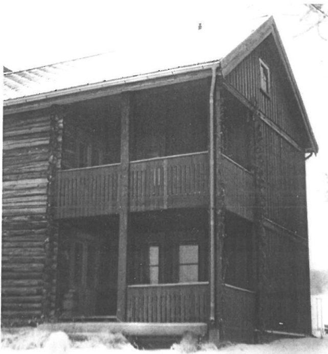
Nytt tilbygg med svalgang.
