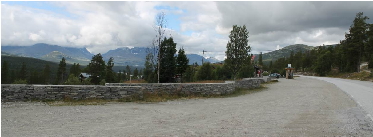
Muren som avgrenser parkeringsplassen
