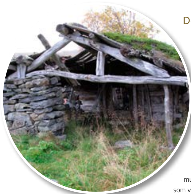
Steinselet ved Skogadalsbøen før restaurering i 2009.
