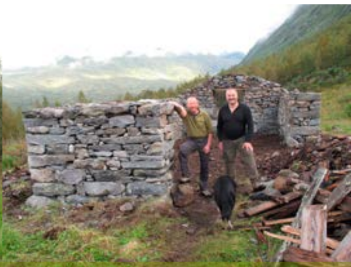
Ferdig restaurert steinmur ved Skogadalsbøen 2011
