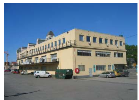
Lagerbygg, Oslo havn. Foto: NIKU
