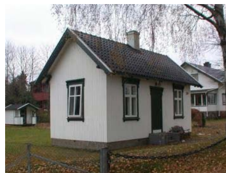
Lite bolighus i Tønsberg kommune. Foto: NIKU
