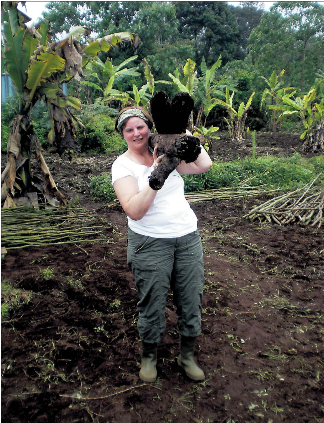
REISVERK: Ellen Marie Tangen bærer fram stokker som skal danne reisverk til bananhuset.
