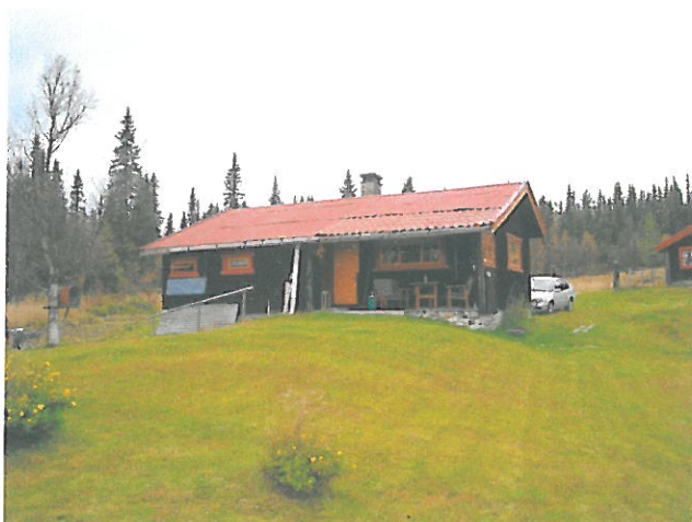
Eksisterende hytte sett fra sørøst.
